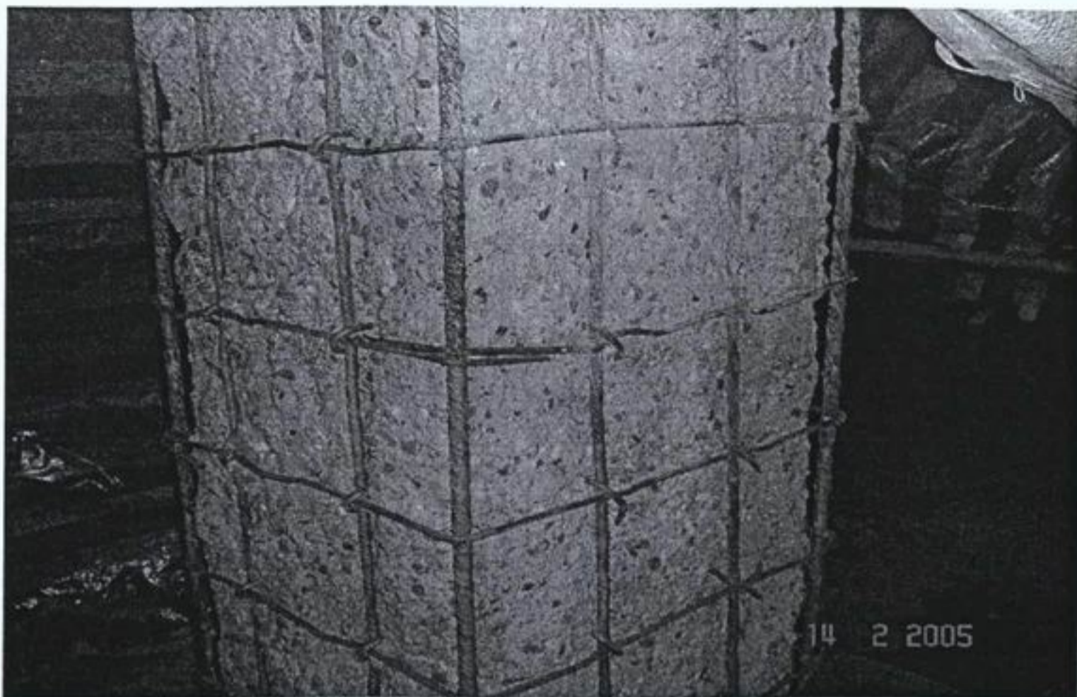
شکل (۵): نمایی از پاکسازی بتن کربناته تا پشت آرماتورها درستون
