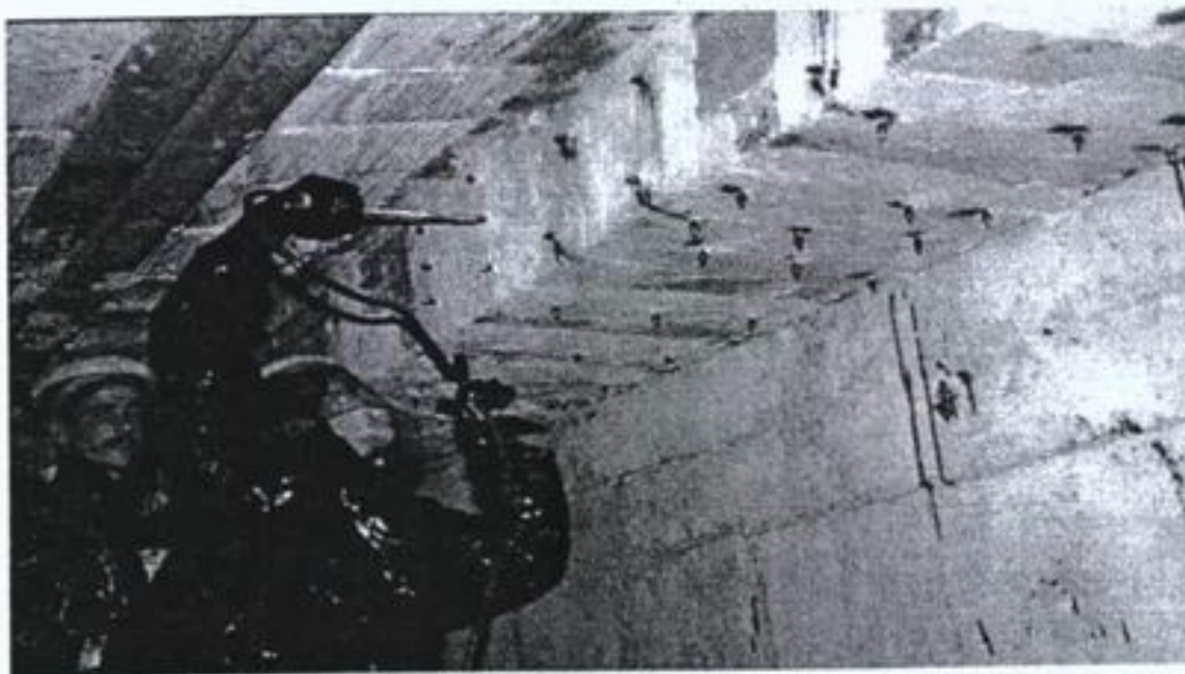
شکل (۴): نمایی از تزریق اپوکسی در ترکها
