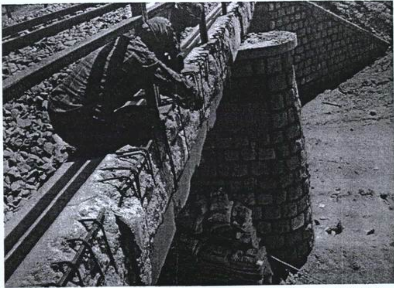
شکل (۷): نمایی از پاکسازی پوشش تیر کناری پل و نمایشی از خوردگی آرماتورها
